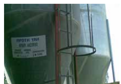
Vstup do obmedzeného priestoru.
