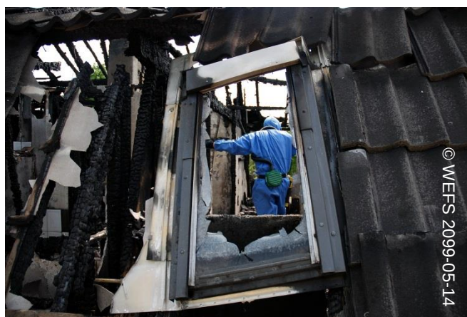
Prace przy usuwaniu azbestu po pożarze
