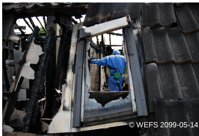
Asbesto pašalinimo darbai po gaisro
