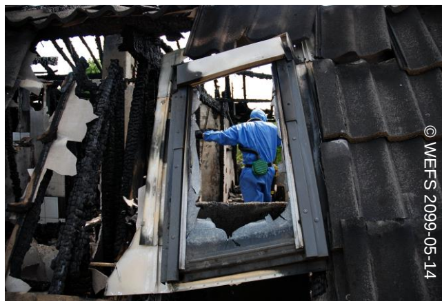
Αφαίρεση αμιάντου μετά από πυρκαγιά
