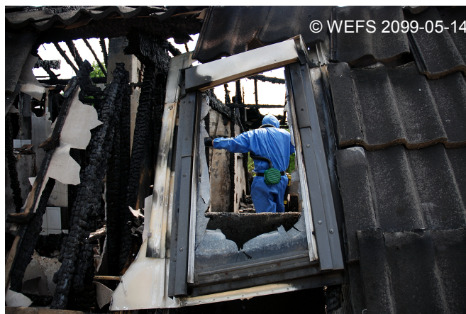
Odstraňování azbestu po požáru
