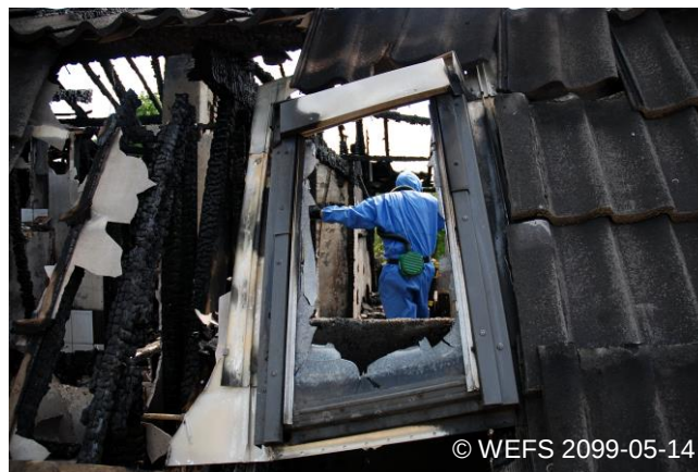
Asbestin poistaminen tulipalon jälkeen
